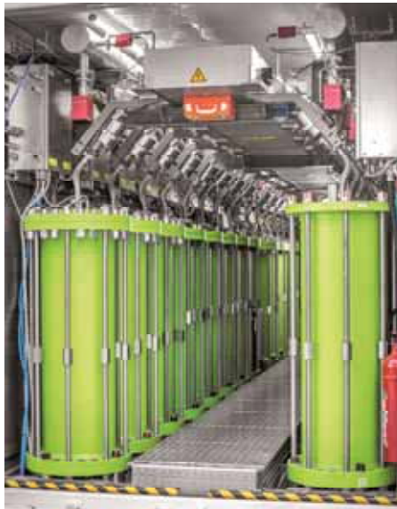
STORNETIC Container in der Innenansicht (oben) und in der Außenansicht (unten): Der kinetische Energieinhalt wird mit einem aus Kohlefasern bestehenden Hohlzylinder gespeichert. Bilder: Stornetic GmbH.
