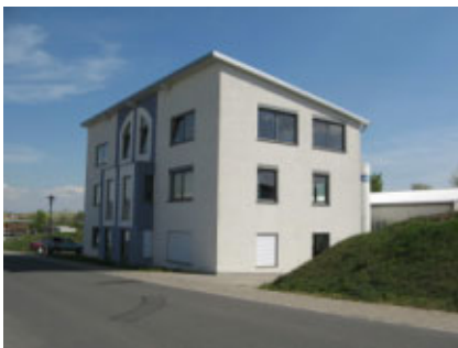
Firmengebäude nanoplus, Nanosystems and Technologies GmbH, Gerbrunn
